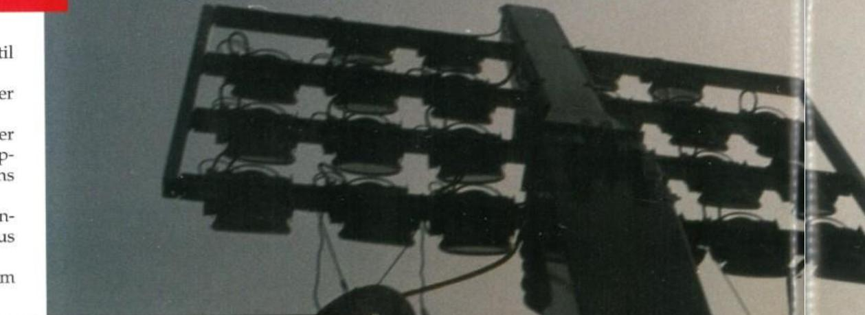
Skala nr. 1 giver 250 lux og bruges ved træning, skala nr. 2 giver 500 lux og bruges ved mindre vigtige kampe, skala nr. 3 er på 1000 lux og bruges ved divisionskampe, og endelig kan skala nr. 4 give 1400 lux som kræves ved internationale kampe under UEFA.
